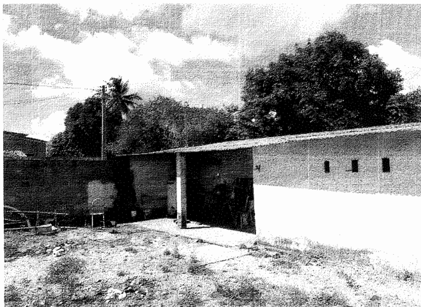
Figura 04 – Escritório do Canteiro de Obras
