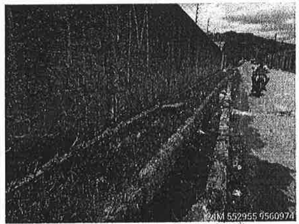
24M 552955 9560974 Visão da valeta que acompanha a rua Isaac Newton
