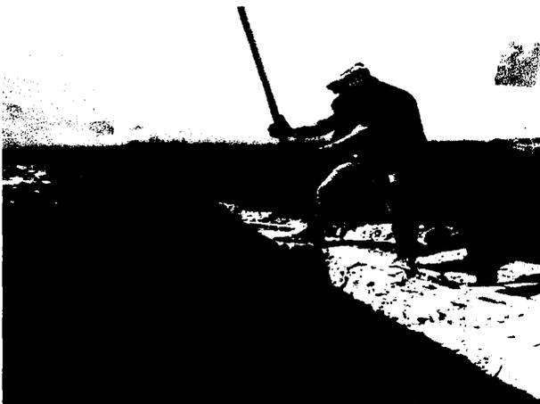
**Foto 03** - Detalhe da abertura da vala para dar início ao Ensaio de Absorção do terreno.
